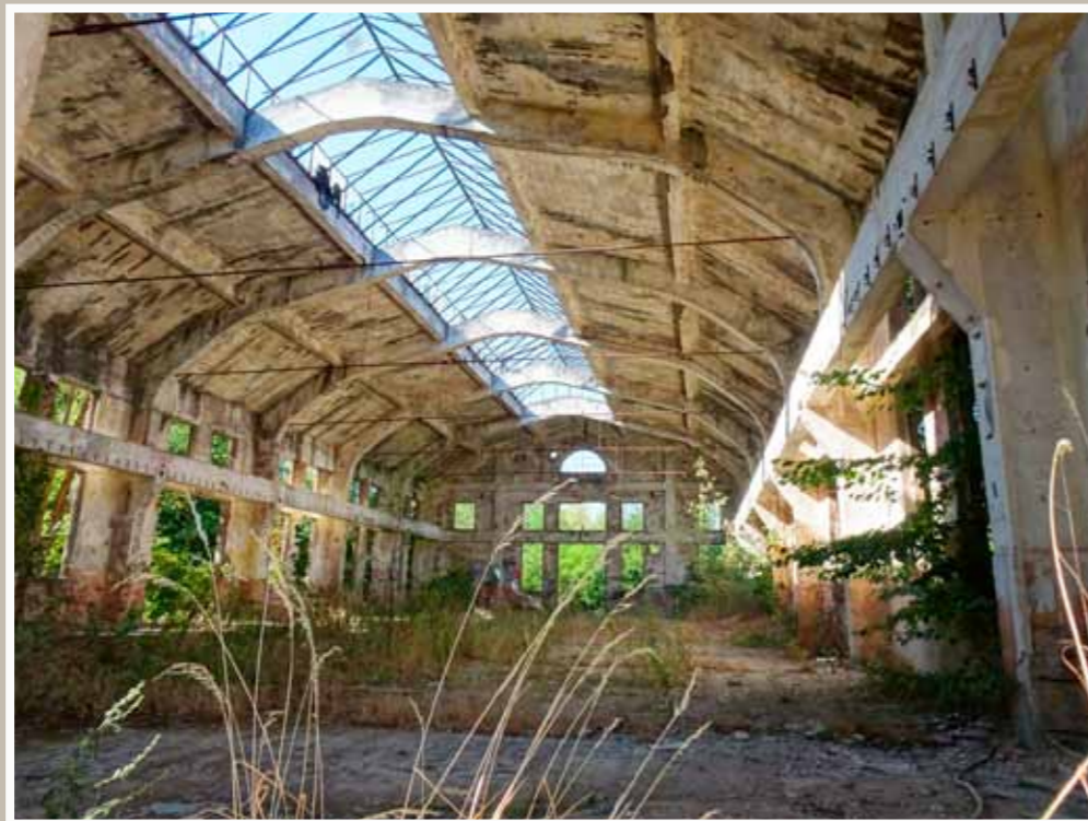
Kompressorenhalle in Frankenholz
