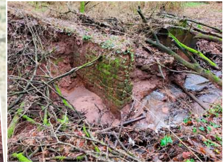
Es wurde ein altes Mauerwerk freigelegt
